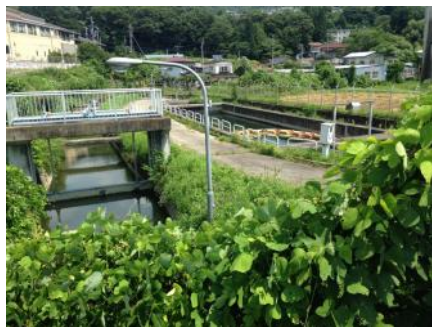
四ツ谷用水（沈砂池）
