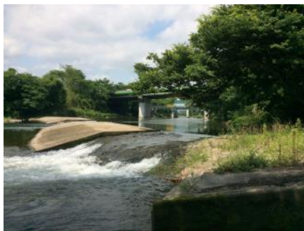
四ツ谷堰（広瀬川）
