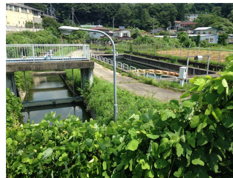
四ツ谷用水 (開水路)と沈砂池
