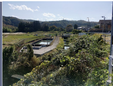
四ツ谷用水 沈砂池(左)と開水路(右)
