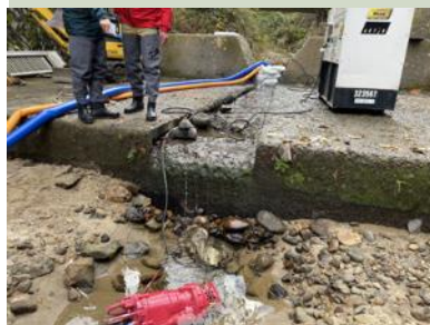
▲竜の口で施工中の切欠き魚道。 (2021.11.11)
