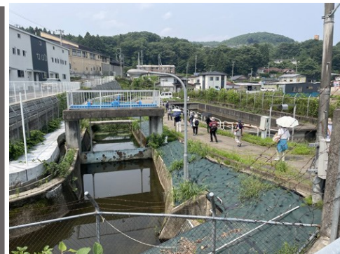
四ツ谷用水 開水路と沈砂池
